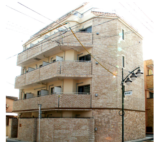
プチグランデロワール 外観
