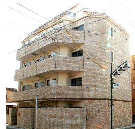
プチグランデロワール 外観
