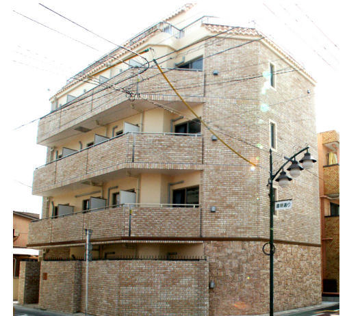
プチグランデロワール 外観
